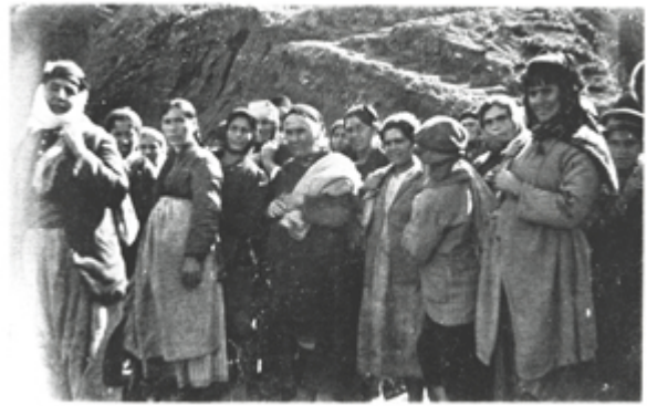
Des Arméniennes affectées aux travaux de voiries. Nr. 26
